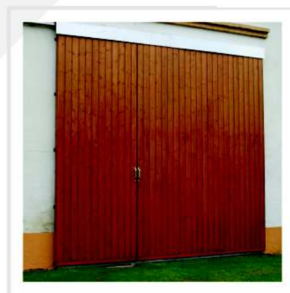
Schiebetor, Holzverschalung Fichte
