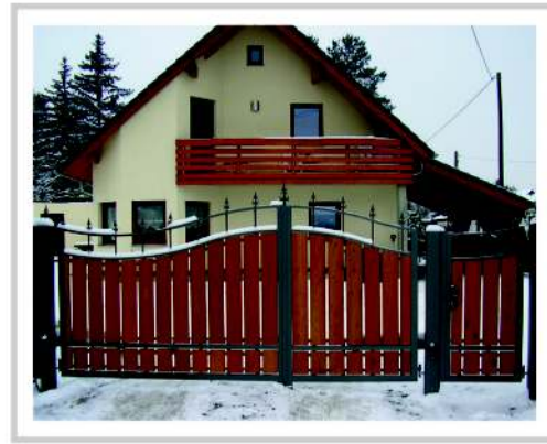
Drehtor, Lattenfüllung Holz und Schmiedestäbe
